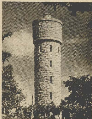
Vodni stolp v Komnu
