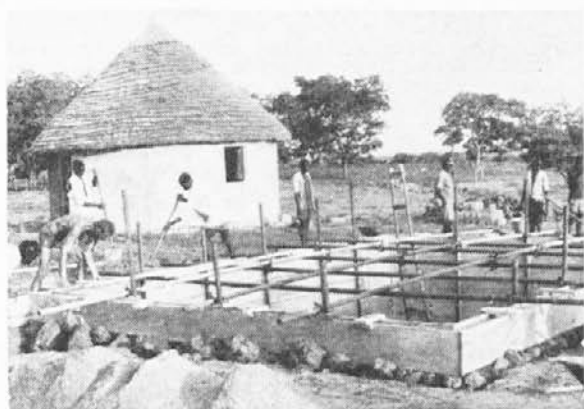
Kljub črnim oblakom afriška Cerkev še vedno gradi... (Okrogla stavba je eden "farovžev" p. Huga, gradbenik na levi — p. Evgen — pa pripravlja formo za moderno cisterno)
