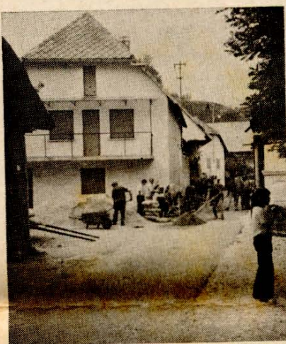
Obnova se je pričela
