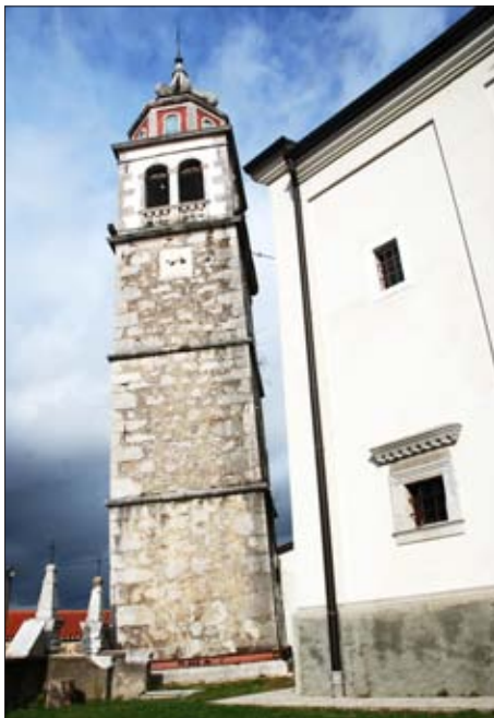
Nagnjen zvonik cerkve sv. Valentina v Črnem Kalu, ki so ga z jeklenico privezali k cerkveni stavbi.
